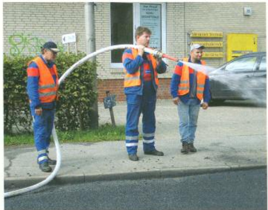
Der neue Asphalt wird mit Wasser gekühlt. | Fotos: Nordlabor
