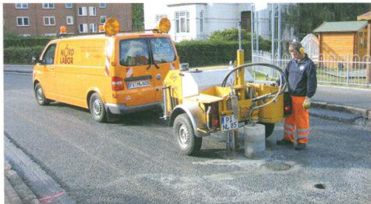
Qualitätssicherung des Einbaus durch Bohrkernentnahmen.
