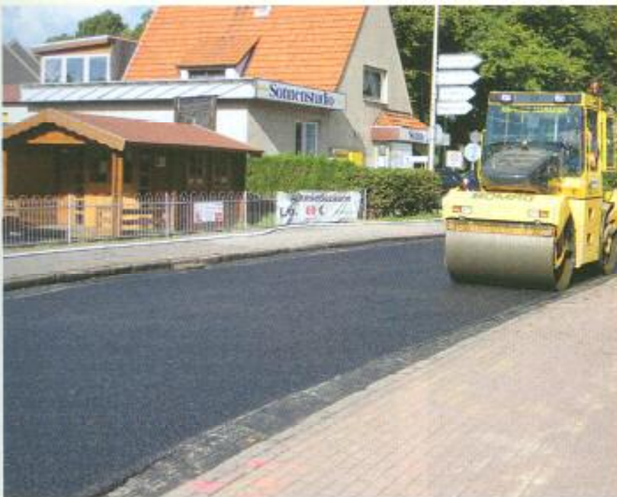
Auch die Verdichtung erfolgt mit konventionellen Walzen.
